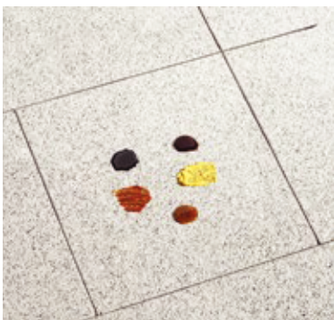
Arcadia® -Platten vor der Reinigung.
