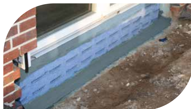
Fenster- und Detailabdichtung
