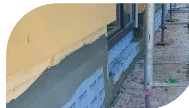
Sockelabdichtung im Holzbau
