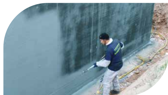
Abdichtung bei tiefen Temperaturen/schneller Baufortschritt, auch bei großen Flächen
