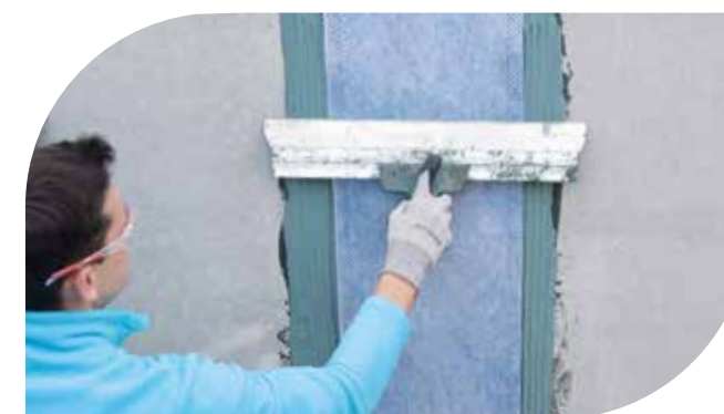
Fugenabdichtung und Abdichtung von WU-Betonbauteilen
