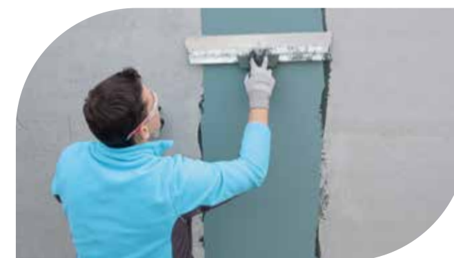
Streifenabdichtung bei WU-Betonkonstruktionen
