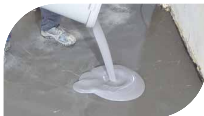
Abdichtung von erdberührten Bodenplatten – Sanierung
