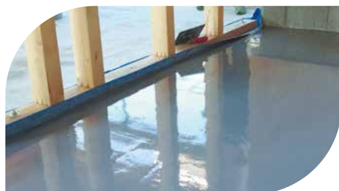
Abdichtung von erdberührten Bodenplatten – Neubau
